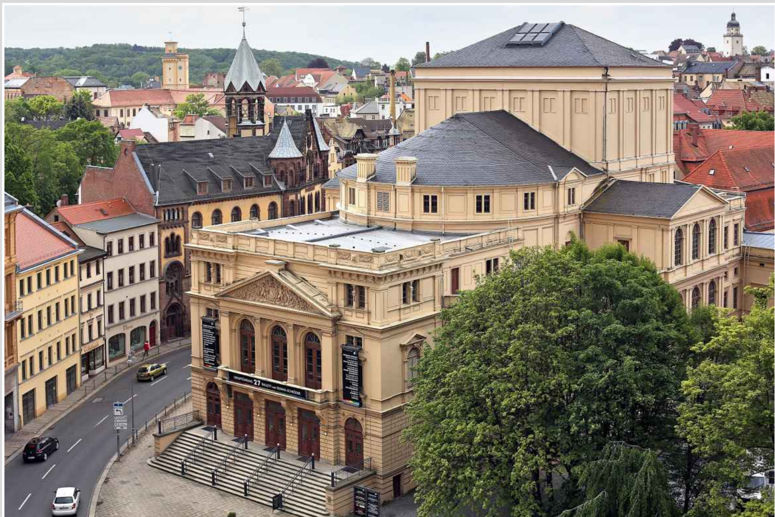
Gera. Wegen der ab 2019 anstehenden Sanierung im Landestheater Altenburg (Thüringen) werden derzeit Ausweichquartiere in der Region gesucht. »Für kleinere Produktionen wie
