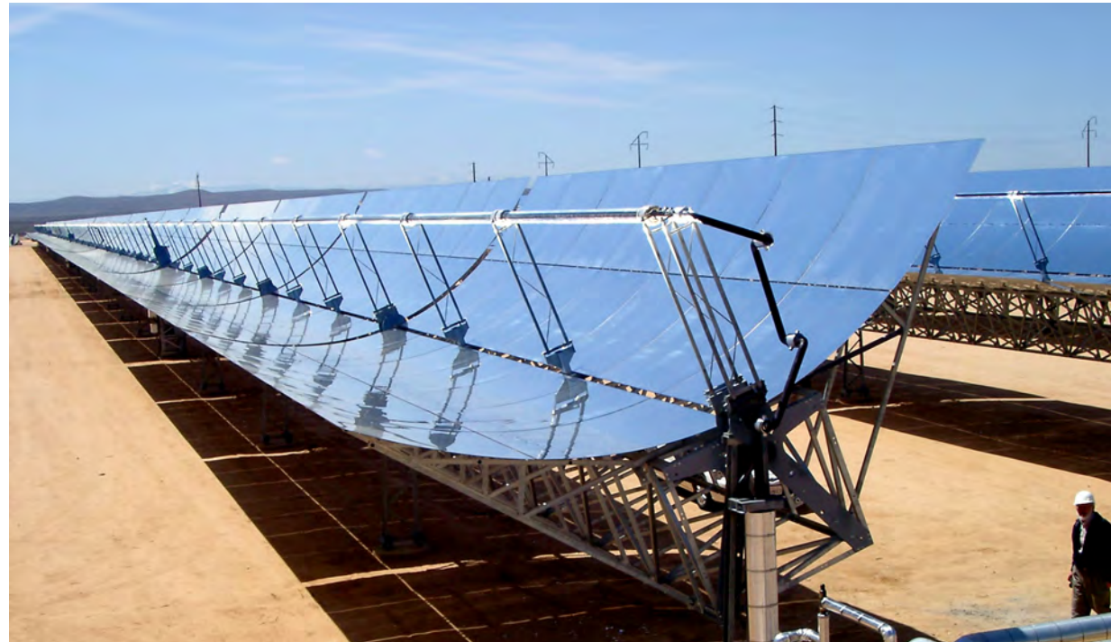
Auch die Cloud braucht Strom
